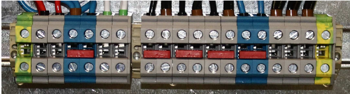
Şekil 2.2 10-15-20-30 kVA Cable Connection
